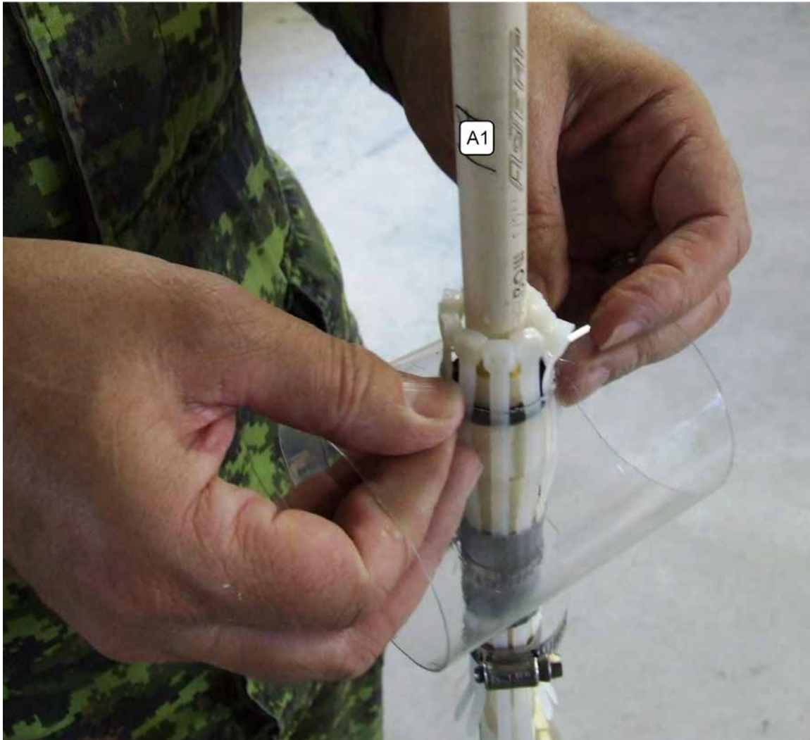
Figure 28-A Glisser le ressort par-dessus les ligatures de câble
