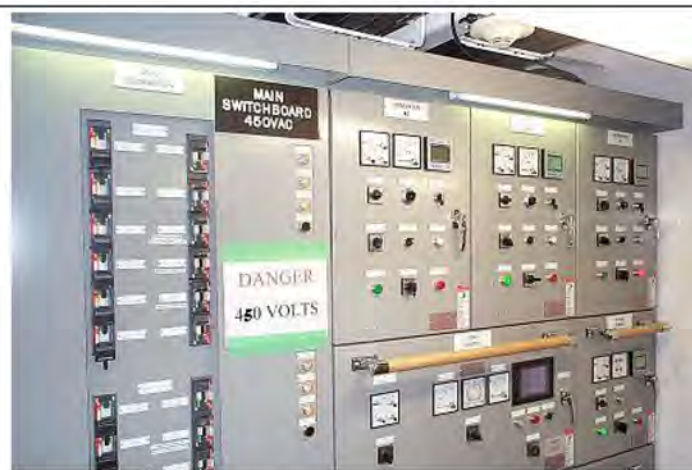
Technicien en électricité
