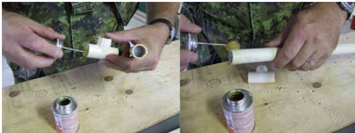
Figure 6-A Appliquer le nettoyant ou la colle sur les joints avant de coller les pièces ensemble.
